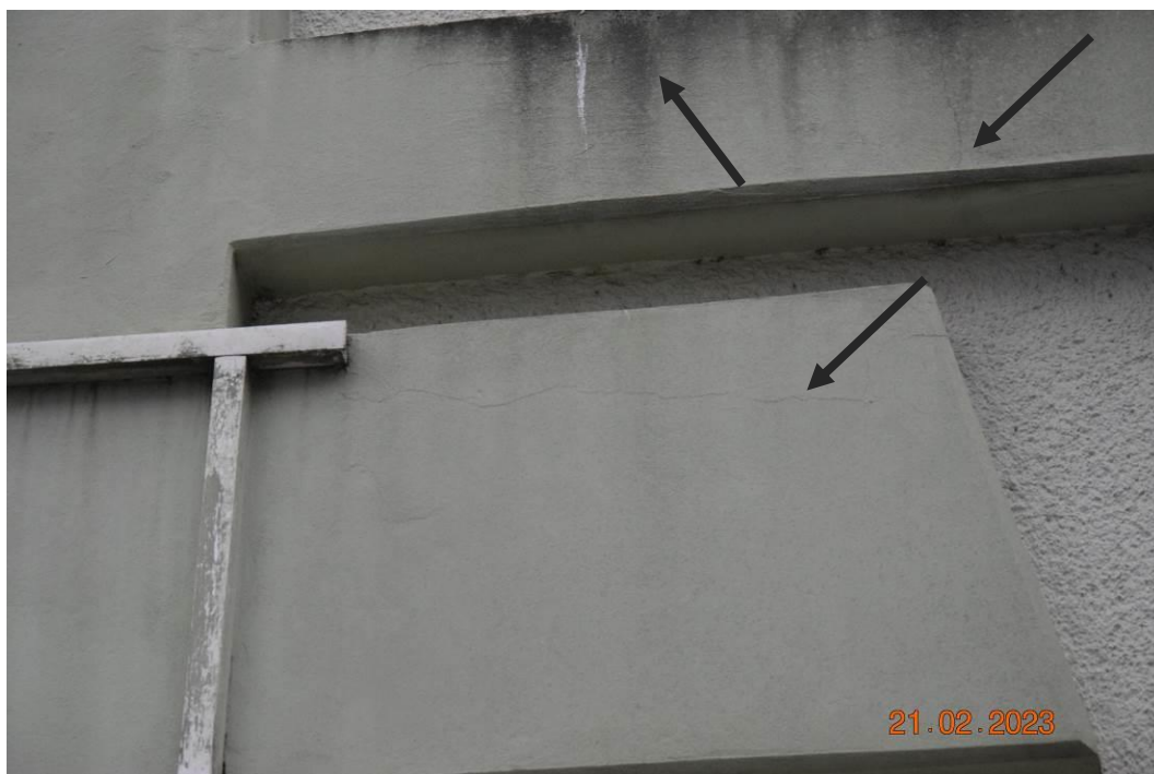
Slika 3-4 Vertikalne in horizontalne razpoke na nosilcu na SZ strani objekta
