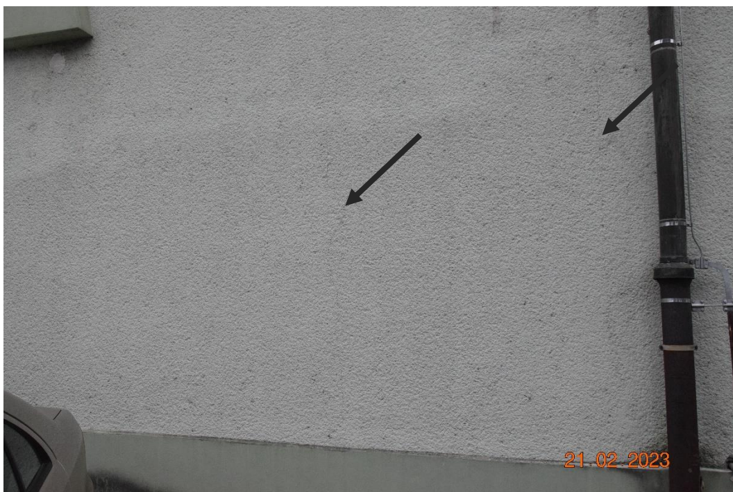
Slika 3-2 Vertikalne razpoke na SZ fasadi
