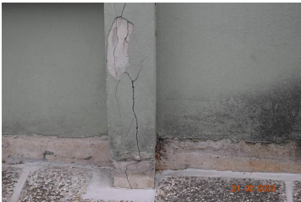
Slika 3-5 Razpoke na stebru na SZ strani objekta
