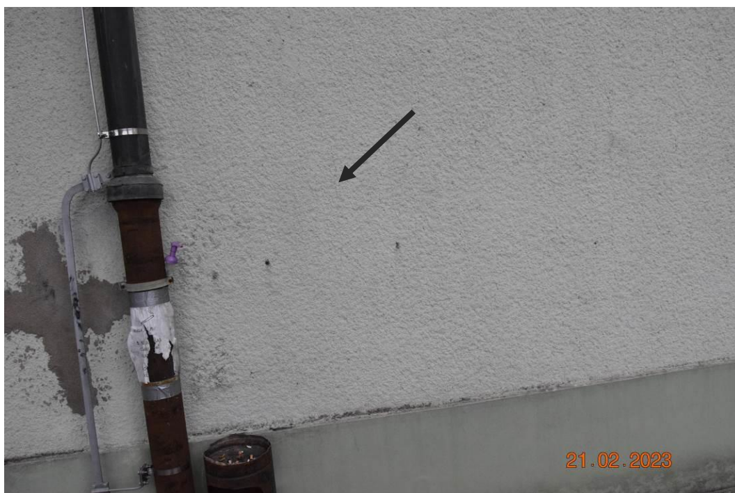
Slika 3-3 Vertikalne razpoke na JV fasadi
