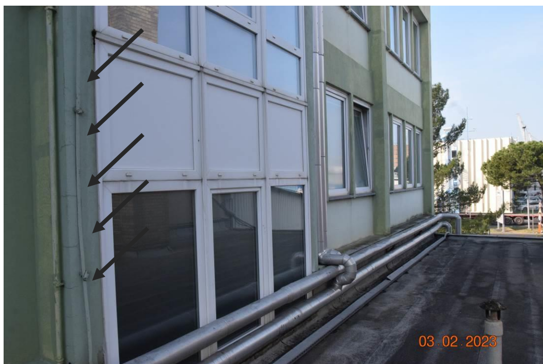
Slika 3-1 Horizontalne razpoke na steni
